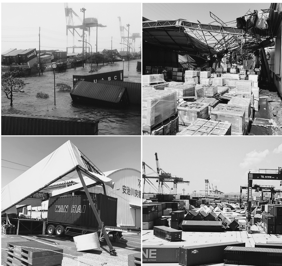
大阪港・神戸港での台風による被害状況
