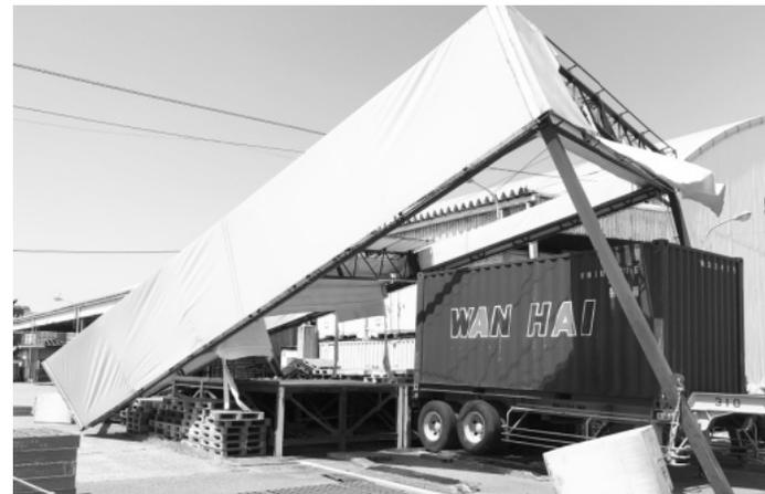
上部は吹き飛び、倒壊した倉庫テント
