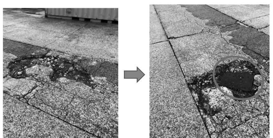
岸壁通路のコンクリート剥離が補修された事例
