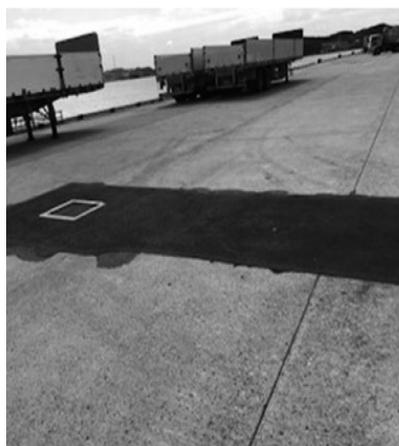
岸壁の排水樹のくぼみが、舗装工事により補修された事例
