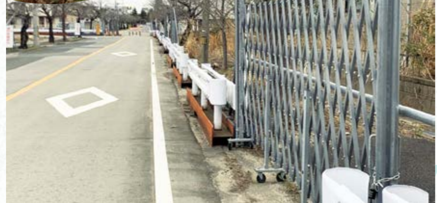
フェンスやロープで仕切られただけの帰還困難区域
