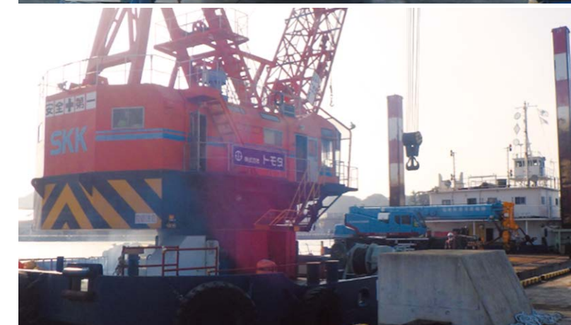
はしけによる移動式クレーンの設置
