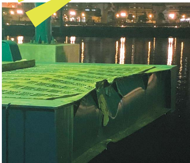
棧橋の破損状況
