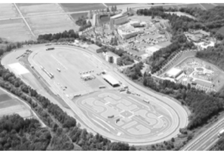
全景 提供：クレフィール湖東
