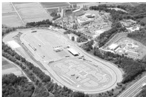
全景 提供：クレフィール湖東
